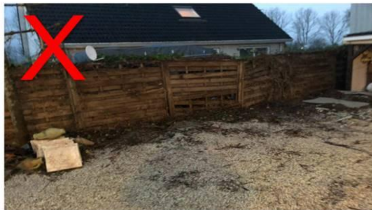
Oude erfafscheidingen dienen verwijderd te zijn
